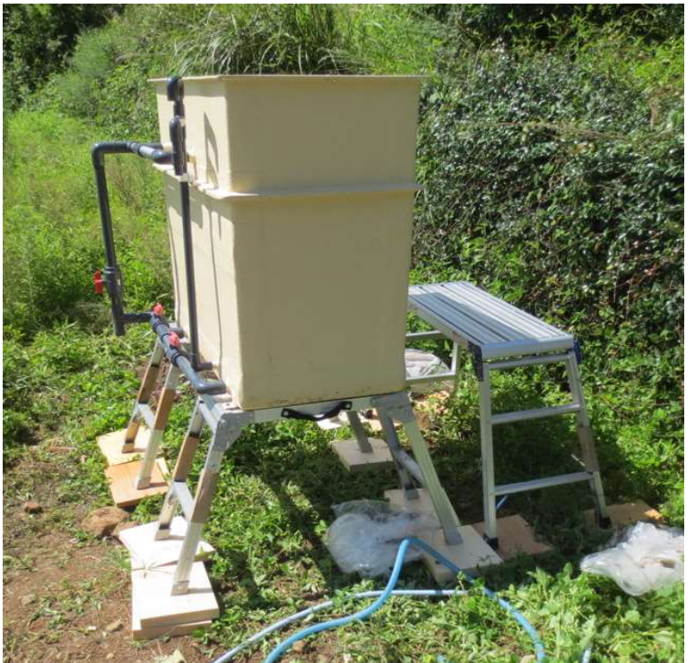
浄水施設設置
