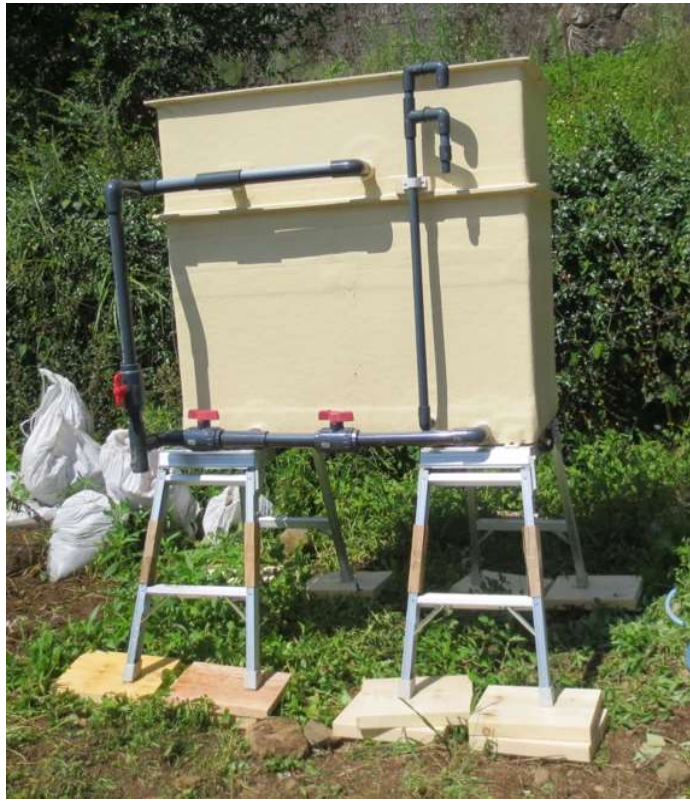
送水ポンプ設置(12V用)
