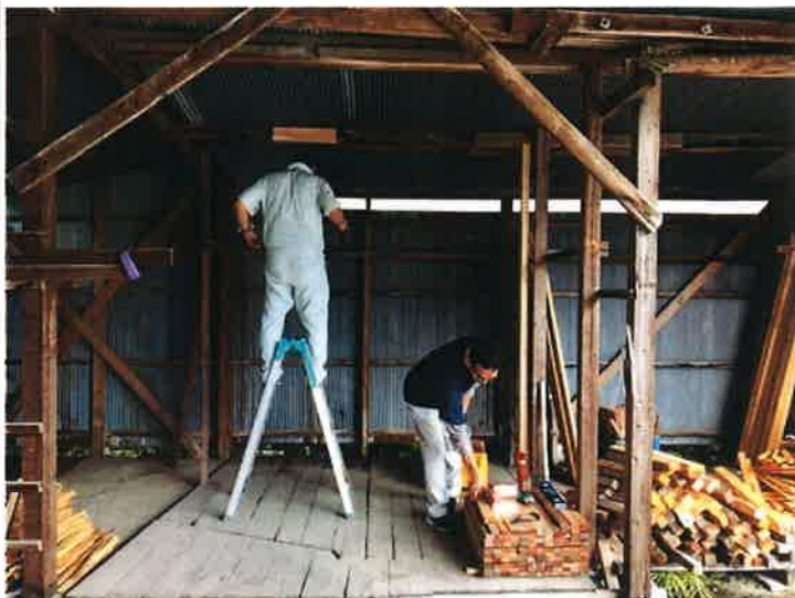
①工事風景写真1
